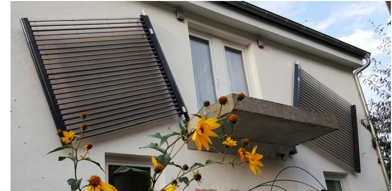
machen: Die Röhrenkollektoren von AKOTEC trotzen selbst Hagelkörnern von vier Zentimetern Durchmesser, das entspricht der Größe eines Tischtennisballs. Diese Robustheit ist schwarz auf weiß belegt, denn die Kollektoren erfüllen als einzige am Markt die Anforderungen der Hagelwiderstandsklasse 4. Für Anlagenbesitzer kann das im Falle von Hagelschäden entscheidend sein, denn angesichts der wegen des Klimawandels zunehmenden Unwetter fordern viele Versicherungen entsprechend zertifizierte Röhren.
